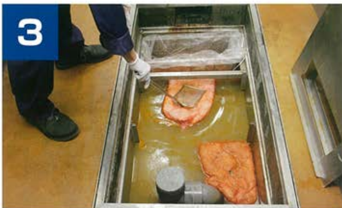
3 油が多い時はオイルホールドを足して使用してください。 十分に油を吸ったものはそのまま廃棄してください。
